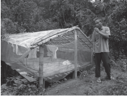
ภาพที่ 32-33 ใช้ลำแก่สร้างโรงเรือนตากซ้า ลำตายใช้เป็นเชื้อเพลิงคว่ซ้า
